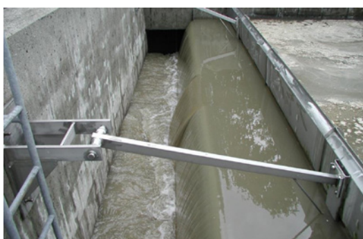
Abbildung 1: Überlaufbauwerk ARA Surental
