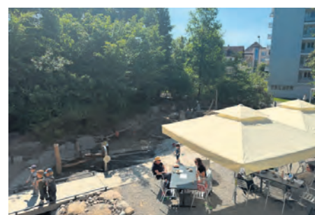
Der alte Spielbereich (oben) wurde komplett neu gestaltet.
