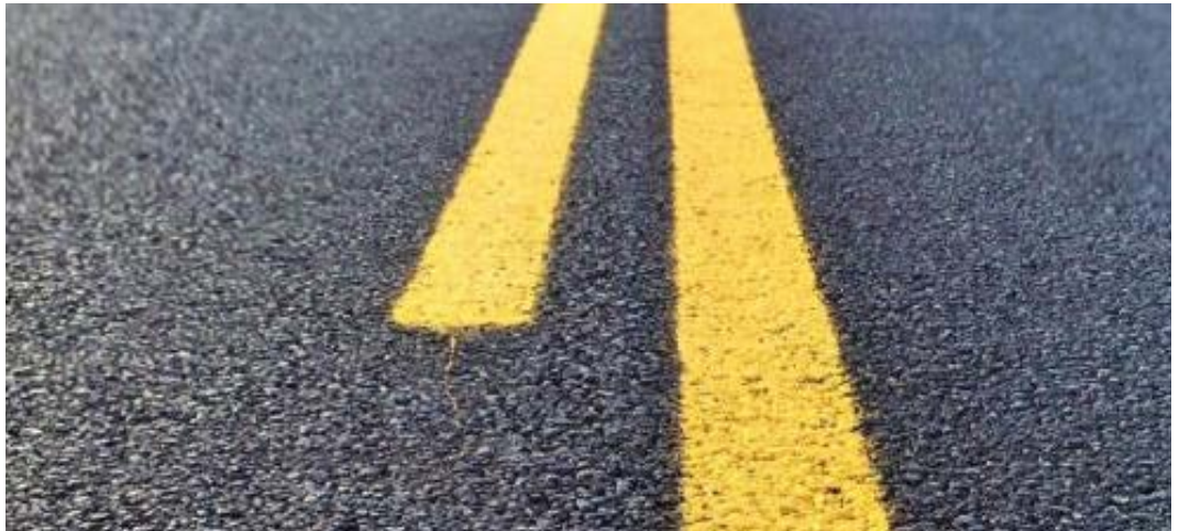
Beispiel eines lärmindernden Asphaltbelags.
