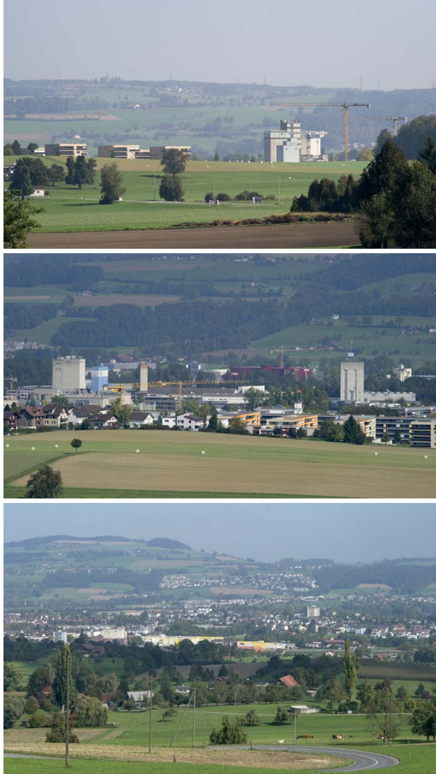
Abb. 32 Annäherung von Westen. Die Silos und die Wohnhäuser greifen unschön in die Geländekante (oben). Die Industrie Süd ist bereits geprägt durch Silobauten (mitte) Das einzige Gebäude, welches das Weichbild der Siedlung durchdringt, ist jenes des Kantonsspitals (unten).
